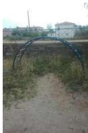
3. **Παιδική χαρά Ερασμίου**: Επικίνδυνες κατασκευές, Το κόστος συντήρησης τους κρίνεται ασύμφορο. Έλλειψη δαπέδων ασφαλείας
